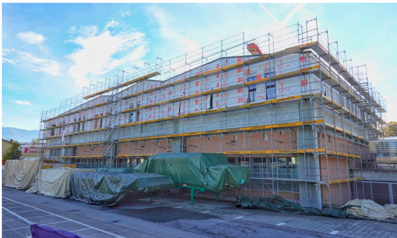
Aufstockung Musik- und Kulturraum Grünau, im Rohbau
