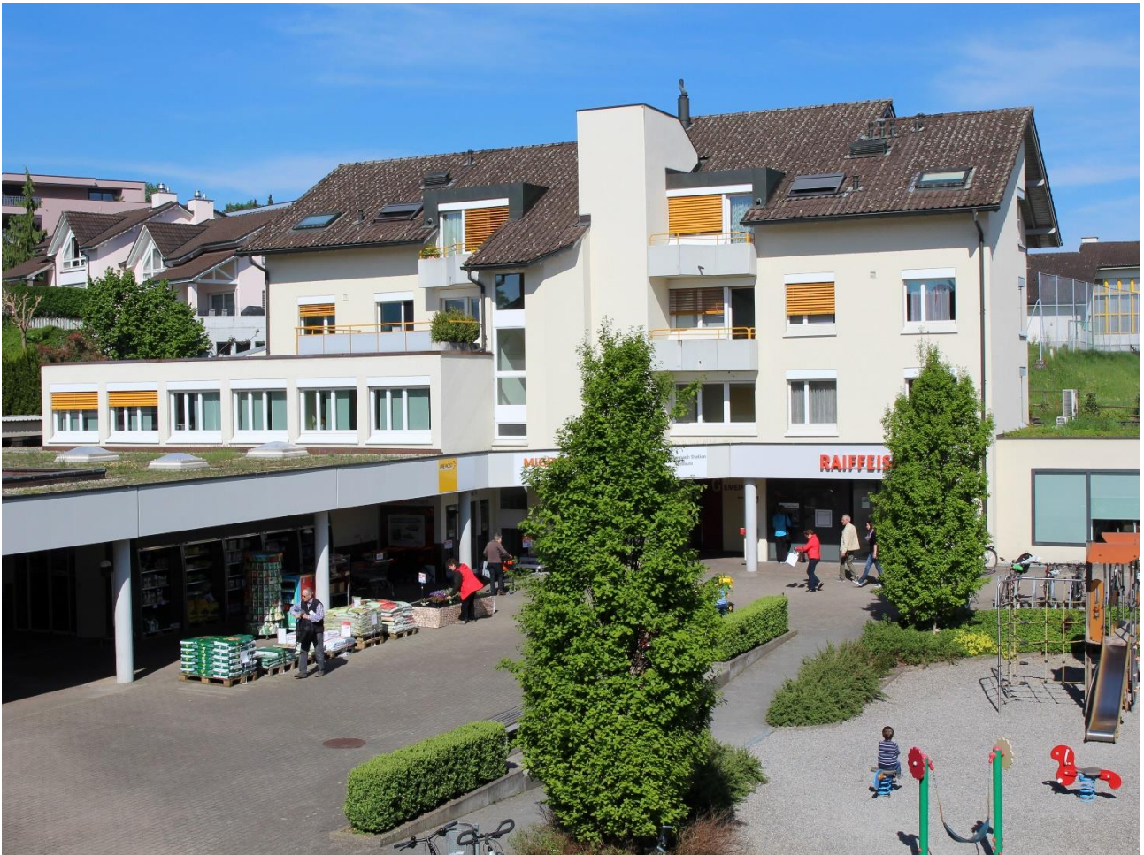
Gemeindeverwaltung im Ladehus Stäg, Neuenkirch
