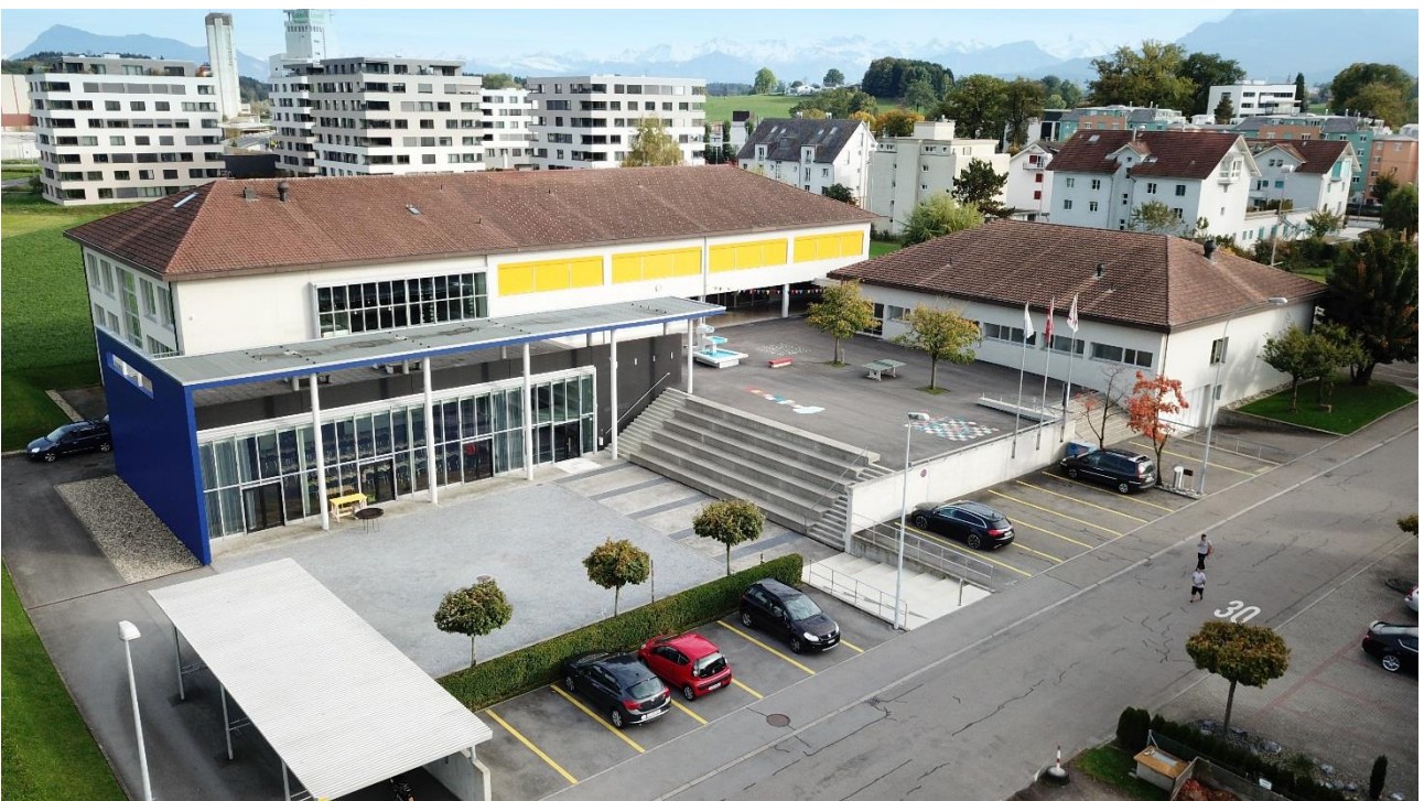
Schulanlage Sempach Station
