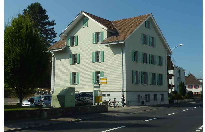
Surseestrasse 19, Klösterli, Ansicht von SO
