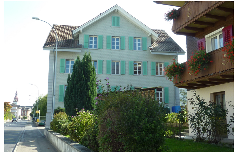
Surseestrasse 19, Klösterli, Ansicht von N
