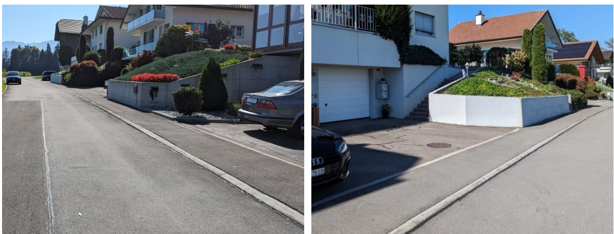
Abbildung 6: Durch bauliche Elemente eingeschränkte Sicht
