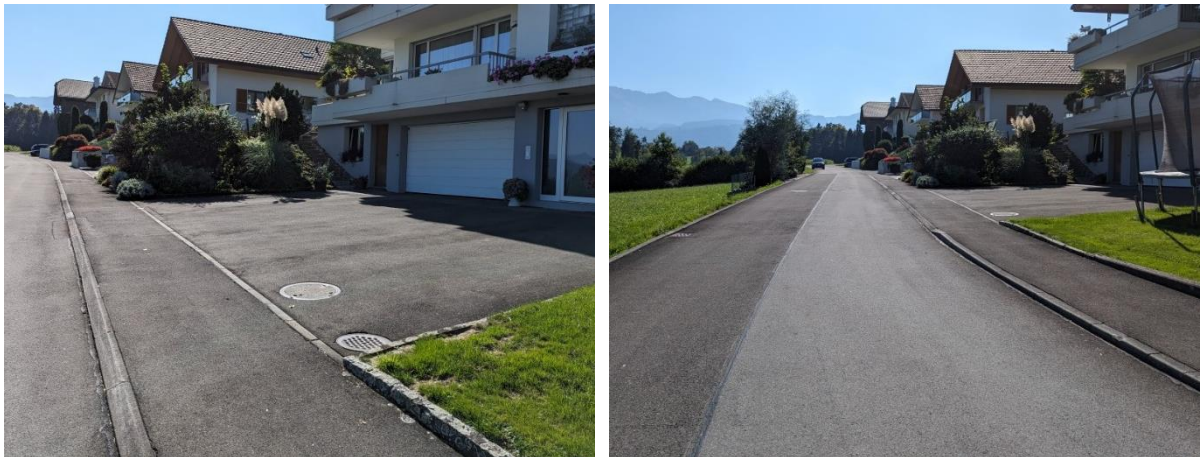
Abbildung 5: Über die gesamte Länge des Trottoirs abgesenkte Randsteine
