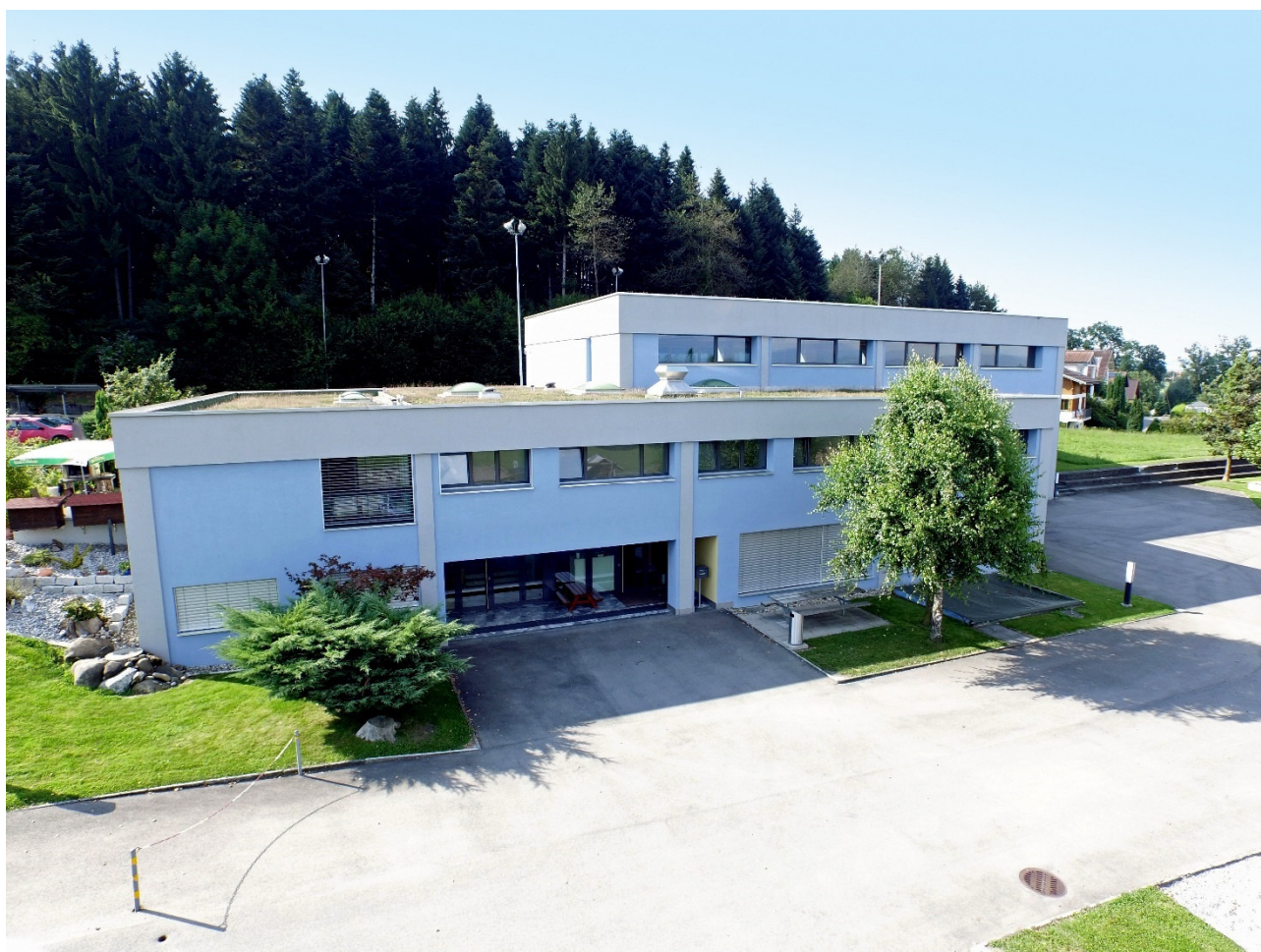
Schulanlage Rotbach, Hellbühl
