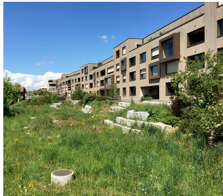
c: Retentionsmulde, Schenkon ©freiraumarchitektur
