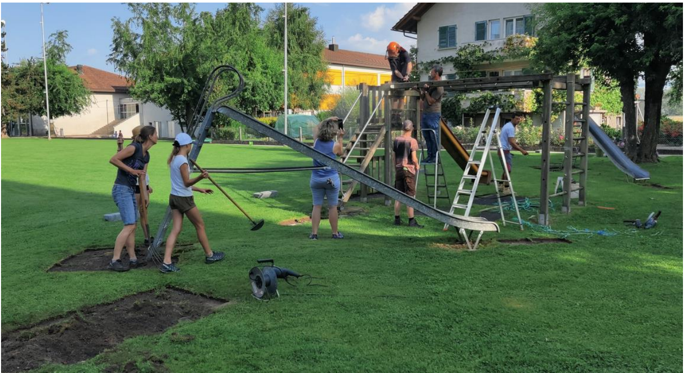
Abbildung 21: Kinder und Eltern helfen mit beim Rückbau
