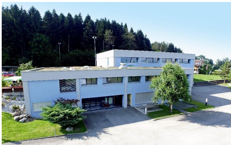
Schulanlage Rotbach, Hellbühl
