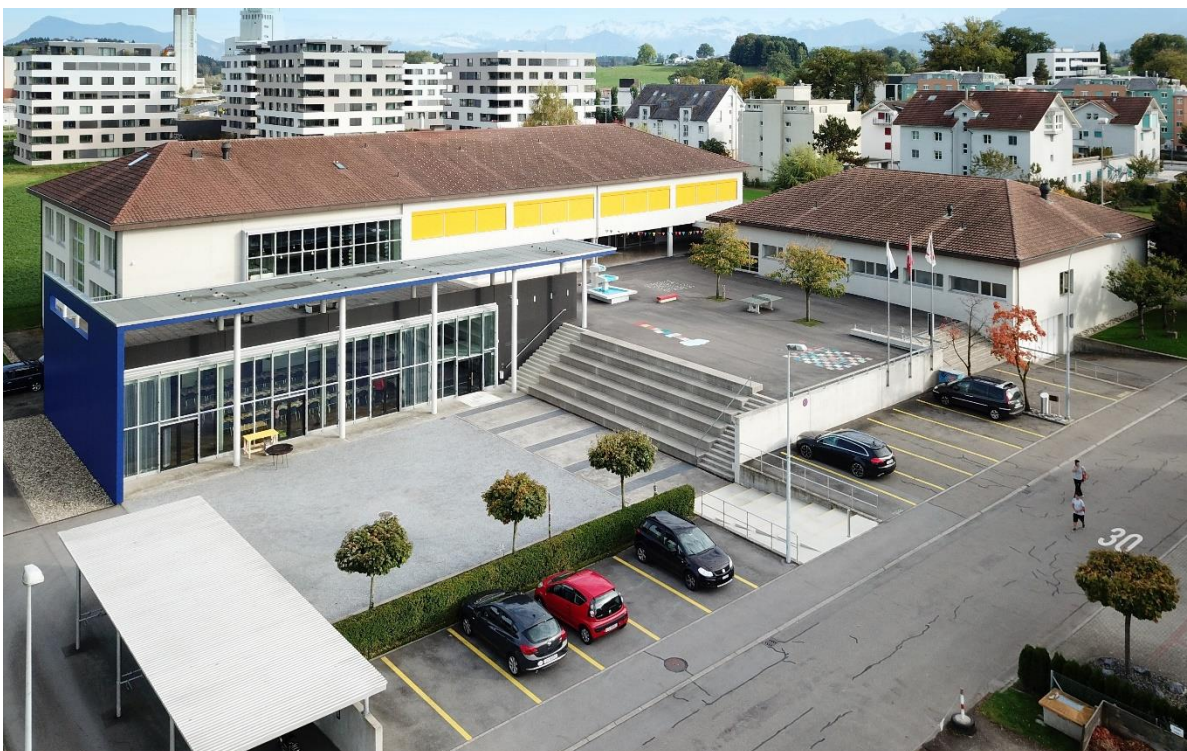
Schulanlage Sempach Station
